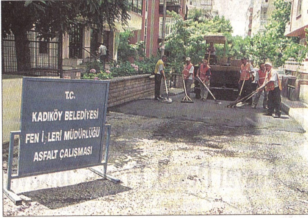
Kadıköy Belediyesi, asfalt çalışmalarını aralıksız olarak sürdürüyor....
